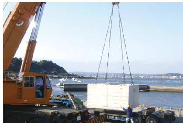
方塊ブロック転置状況
