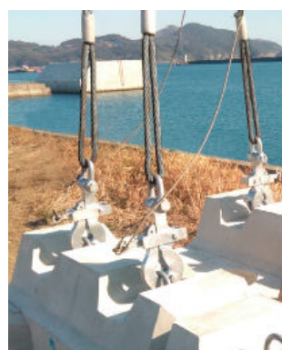
※吊鉄筋直掛け使用
