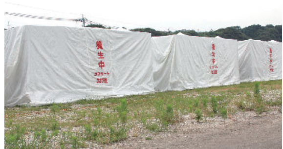
根固方塊ブロック
