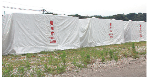
根固方塊ブロック
